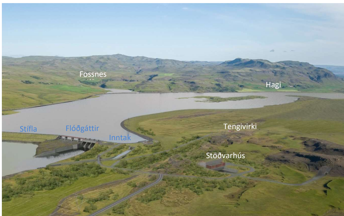
Mynd 4. Mannvirki og Lón Hvammsvirkjunar teiknuð inn á ljósmynd af svæðinu (Mannvit 2020).
